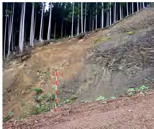
細密な地形図を用いて斜面のリスクを評価した図。右写真は左図の写真1である。この部分のみ崩壊面が茶色に風化・軟弱化しており、ボールの左側の斜面が北側に徐々に移動中（崩壊が進んでいる）。
