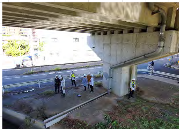
橋梁下部の変状についてドローンを用いて近接写真を撮影することで、クラックや鉄筋のさびなどを見分ける技術を体験します（地学実習）
