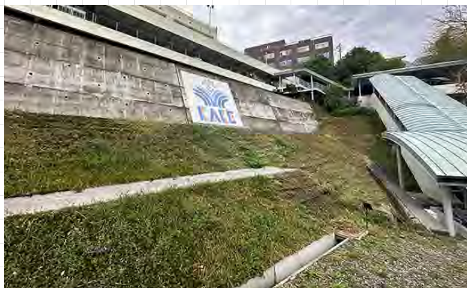
学内の防災対策について現地で説明。斜面が多い本学では多種類の対策が施されており、それぞれの意味について考えます（野外調査法実習Ⅰ）
